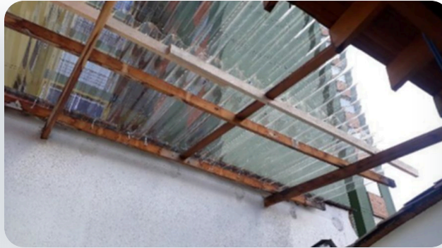
Instalación de tejas acrílicas sobre estructura de madera
