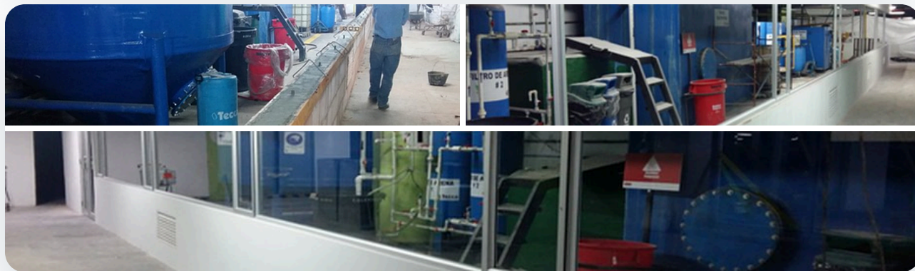
Cerramiento, ventanería y techos para la PTAR de Mall Plaza, Bogotá
