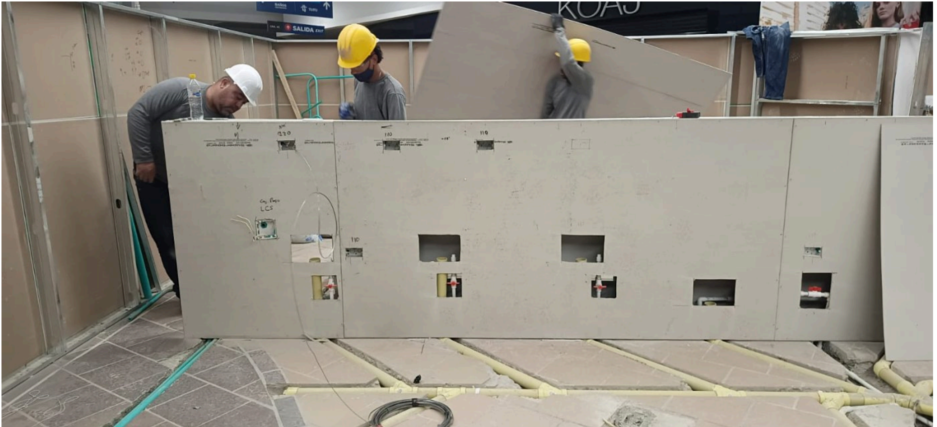
Interventoría y dirección técnica en obra
