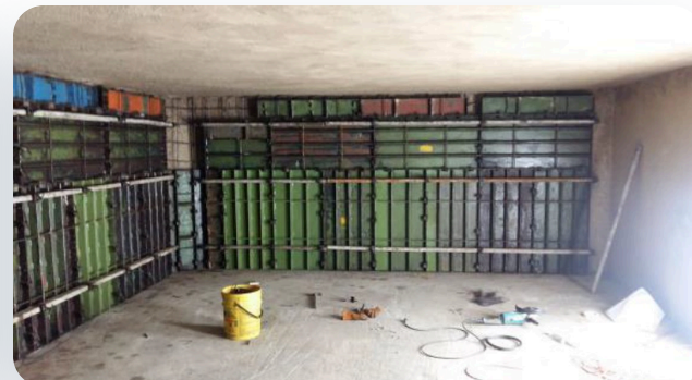
Reforzamiento estructural con formaleta
