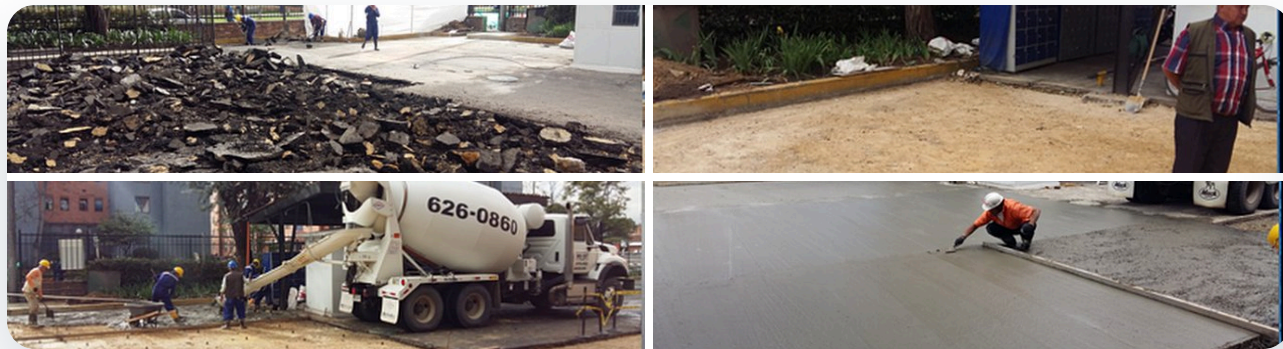
Construcción de losas de concreto: demolición, preparación, vaciado y acabado
