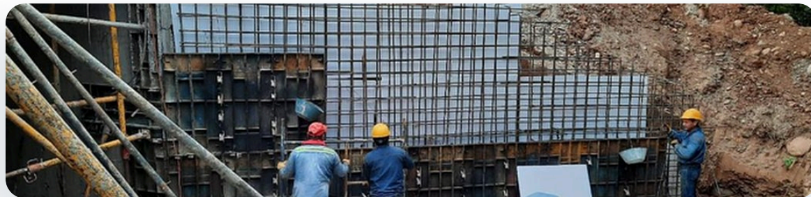
Construcción de boxculvert, gaviones y atención a urgencias en la vía Granada – San Juan de Arama (Meta)
