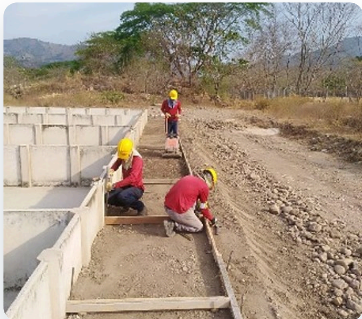
Construcción de andenes en Yopal
