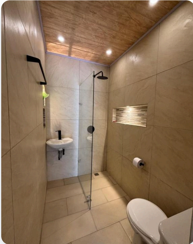
Enchape de muros y pisos, Finca Santa Helena
