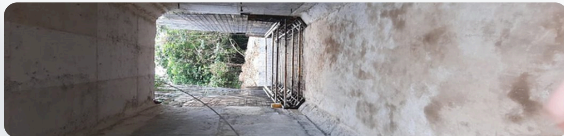
Interior del boxculvert, vía Granada – San Juan de Arama (Meta)
