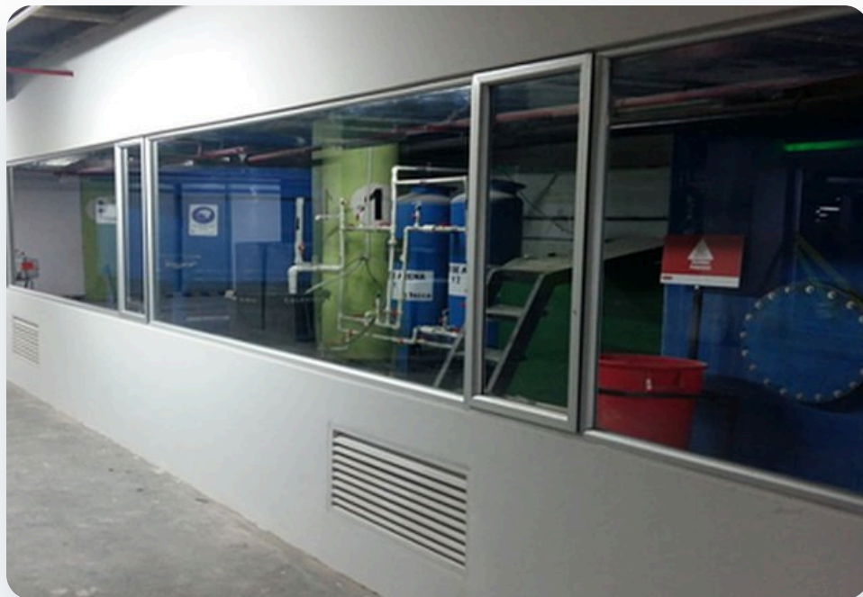
Cerramiento, ventanería y techos para la PTAR de Mall Plaza, Bogotá
