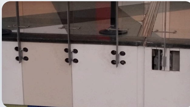
Anclajes para barandas de vidrio
