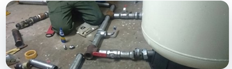
Instalación de tuberías en tanque hidroneumático
