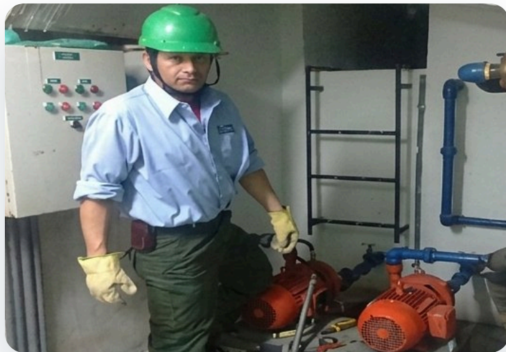
Mantenimiento de bombas de presión
