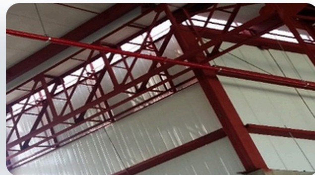
Redes contra incendio en hangares
